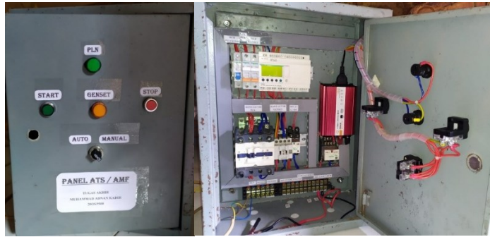
Gambar 6. Hasil rancang bangun sistem ATS/AMF
