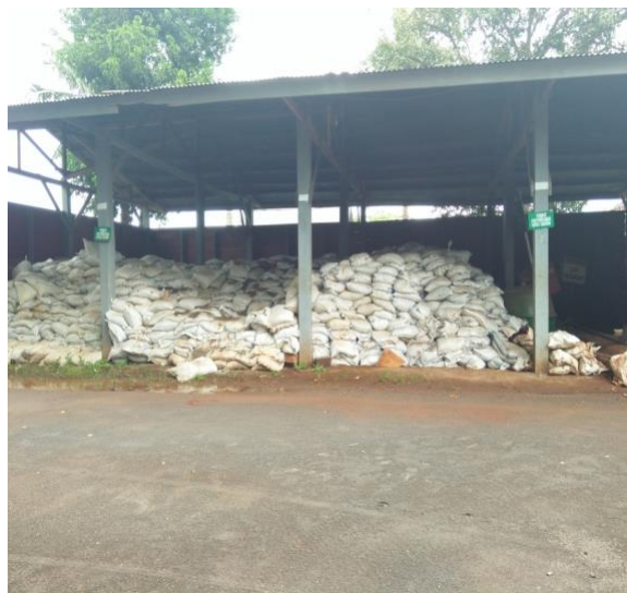
Gambar 1. Kondisi awal gudang penyimpanan pupuk PT XYZ Sumber Data PT XYZ
